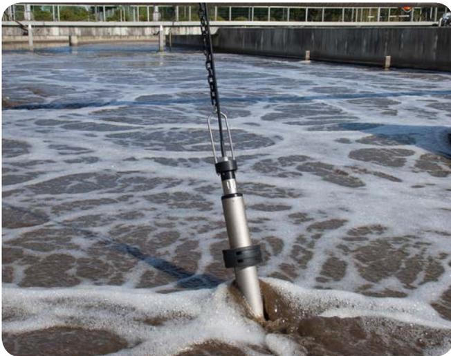
(Elektrodenhalterung EH/U 170 in Kombination mit Schwinghalterung EH/F 170-1,5)
